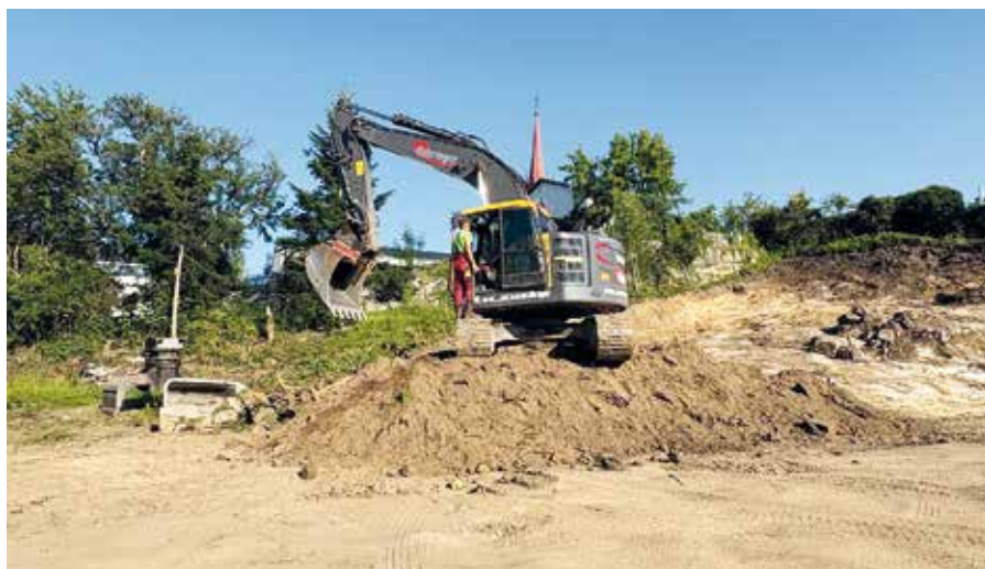
Mit den Bauarbeiten wurde bereits begonnen und sie schreiten zügig voran.
